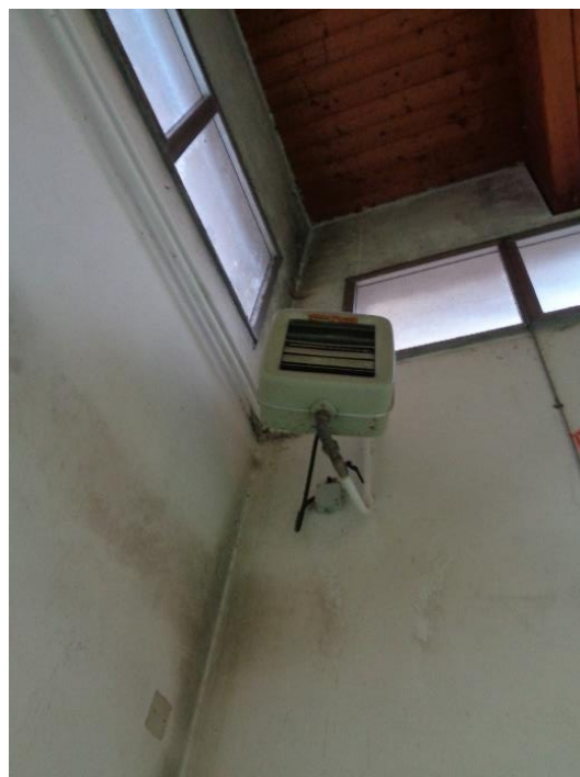
Figura 4.7 - Particolare Aerotermo
