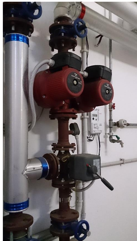
Figura 4.9 – Particolare della valvola di regolazione a tre vie
