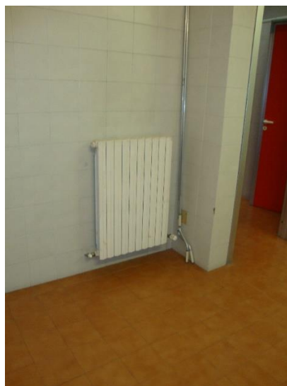
Figura 4.5 - Particolare radiatore in ghisa
