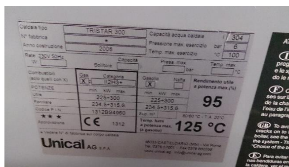
Figura 4.14 - Particolare di dati di targa caldaia
