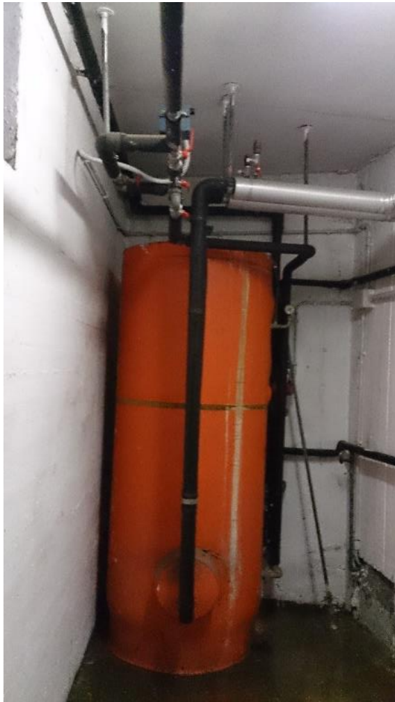
Figura 4.15 - Particolare di preparatore acqua calda sanitaria
