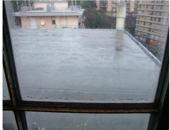
Figura 4.3 - Particolare dei serramenti
