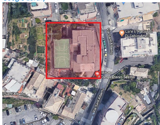
Figura 2.2 - Vista satellitare dell'edificio (Fonte: Google Earth)
