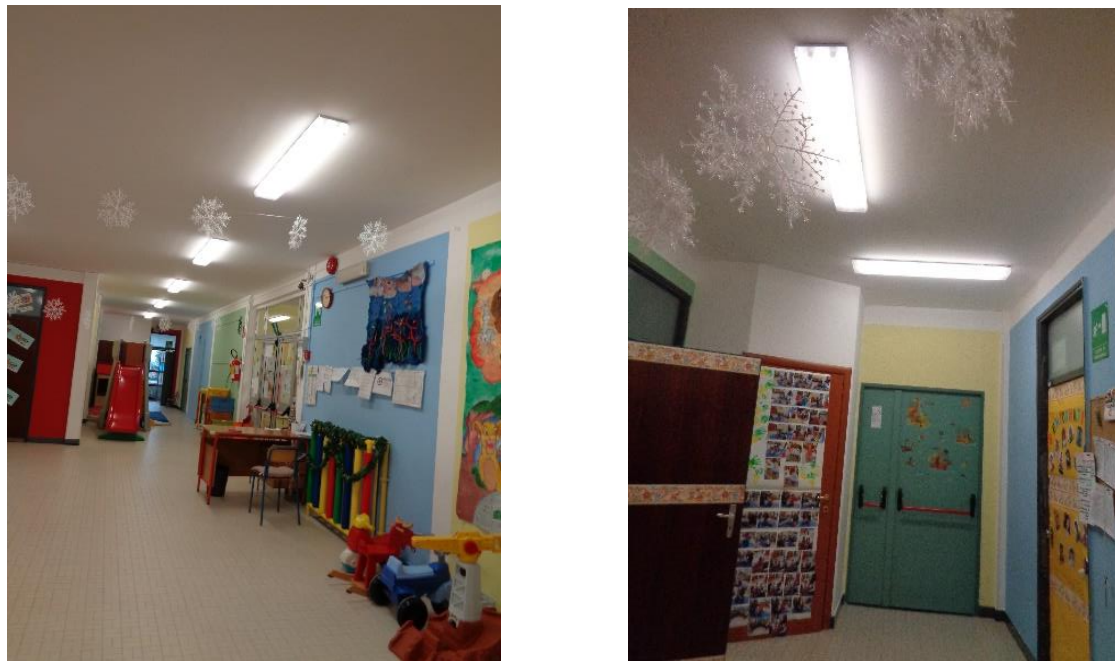
Figura 4.21 - Particolare dei corpi illuminanti fluorescenti 2x58W installati nelle aule e nei corridoi
