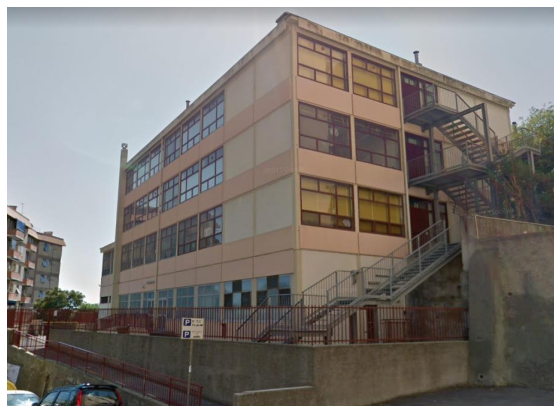
Figura 1.1 - Vista della facciata a Est
