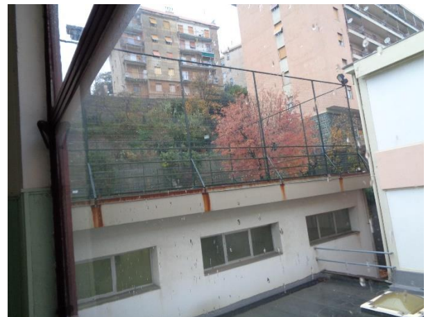
Figura 4.1 - Particolare della porzione di involucro
