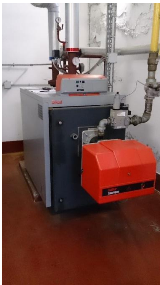
Figura 4.13 - Particolare di Caldaia Tradizionale UNICAL TRISTAR 300
