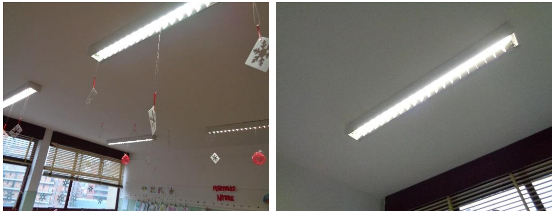
Figura 4.21 - Particolare dei corpi illuminanti fluorescenti 2x58W installati nelle aule e nei corridoi
